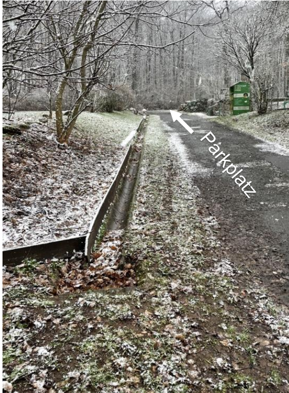
Abbildung 32: Oberflächenentwässerung mit Rinnen
