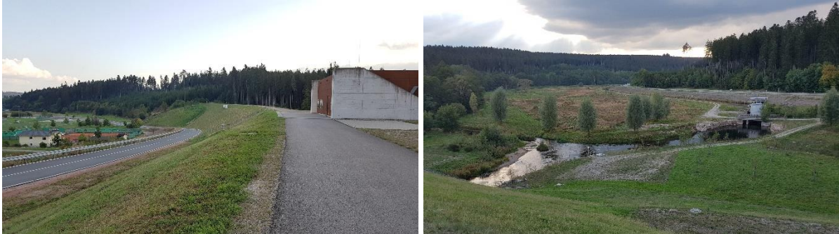
Abbildung 57: Beispiel Hochwasserrückhaltebecken Wolterdingen im Donau-Einzugsgebiet (max. Dammhöhe 18 m, Stauraum 4,7 Mio. m 3 , Bemessung auf ein 100-jährliches Hochwasser)
