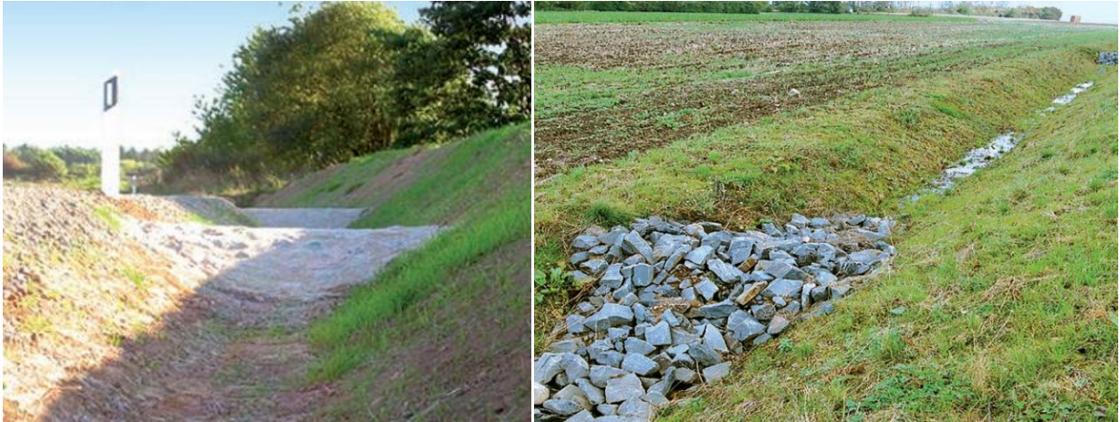
Abbildung 25: Beispiele: Mulden-Kaskaden-Systeme (Quelle: Niederschlagsentwässerung von Verkehrsflächen, umwelt.nrw.de)
