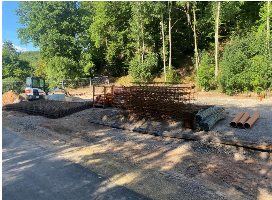
Baustelle im nördlichen Teil des Grundstücks
